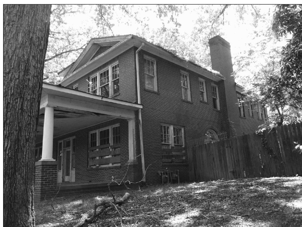
3 EXISTING PHOTOS SCALE: NONE
