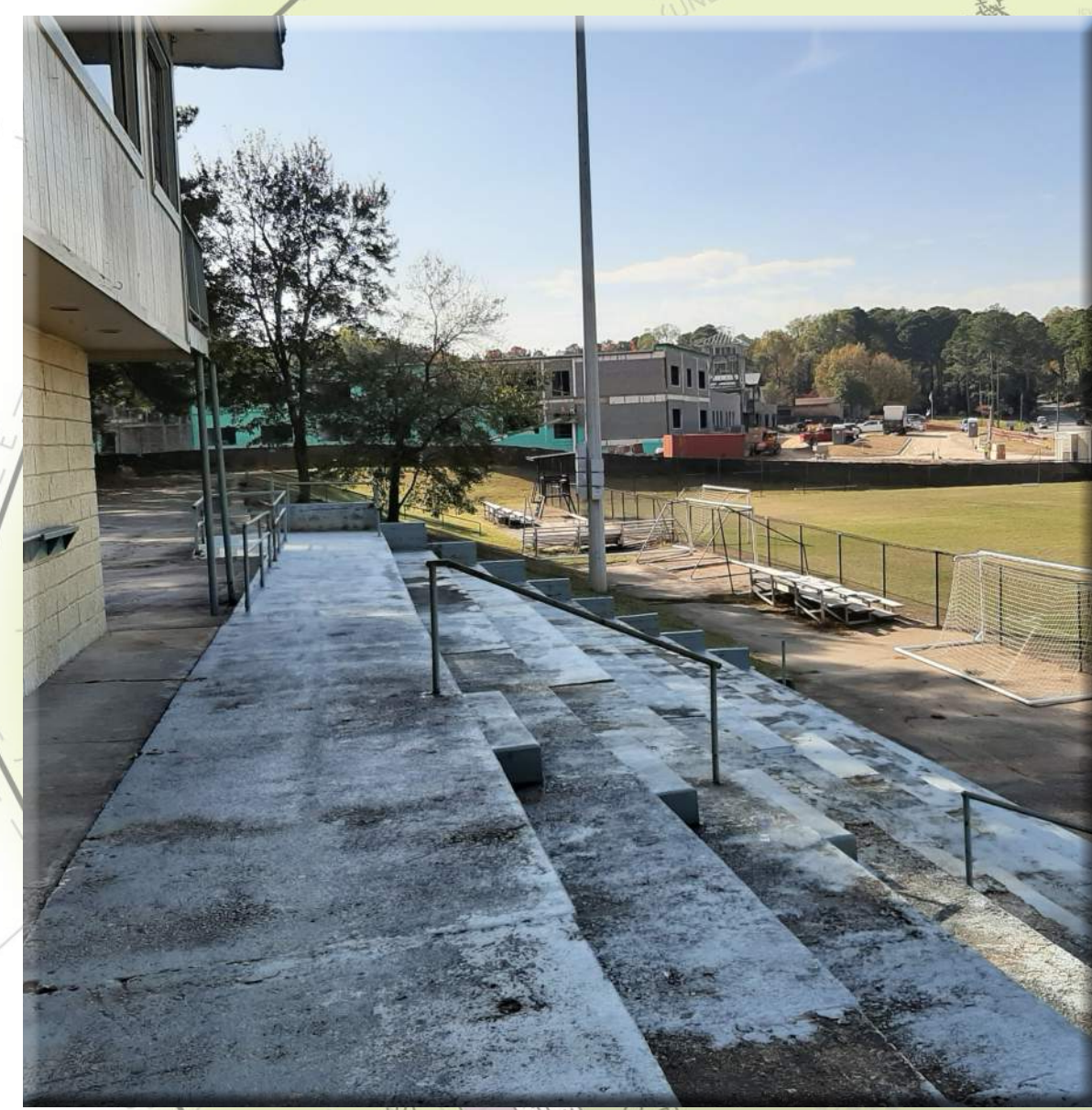
Bleachers Gradas Descubiertas
